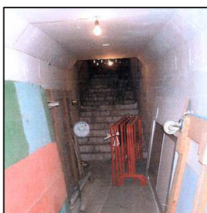
Escaleras de acceso
