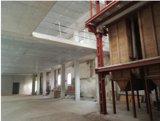
Silo y PB del bloque Burben antes de las obras de habilitación
