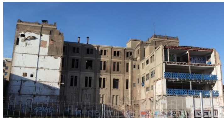
Foto de parte posterior del edificio ( Año 2013)
