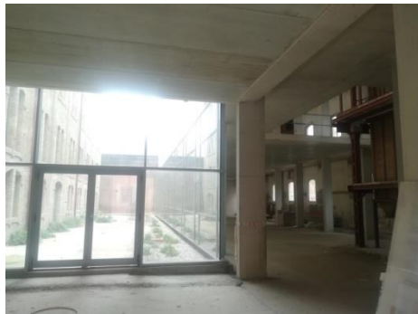
Vista del patio central y PB bloque Burben antes de las obras de habilitación
