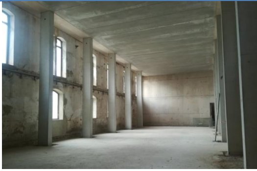
Sala multiusos en PB bloque central antes de la rehabilitación
