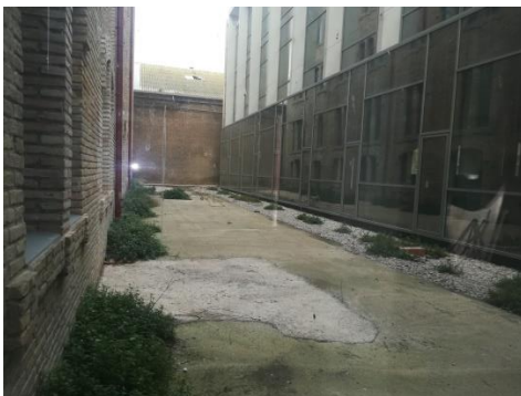
Patio central antes de las obras de habilitación
