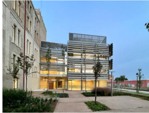
Jardín después de las obras de rehabilitación
