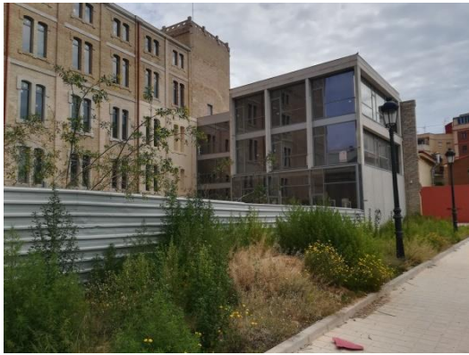
Jardín y vista bloque Anexo antes de las obras de habilitación
