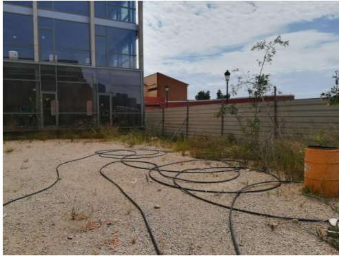
Jardín antes de las obras de rehabilitación
