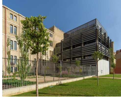
Jardín y vista bloque Anexo después de las obras de habilitación
