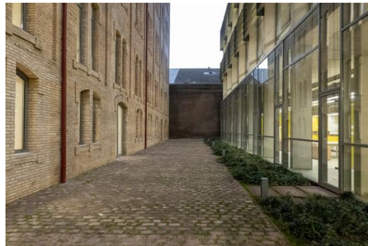
Patio central después de las obras de habilitación
