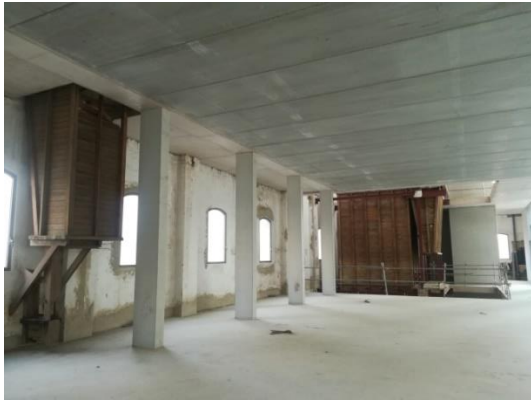
P1 bloque Burben antes de las obras de habilitación
