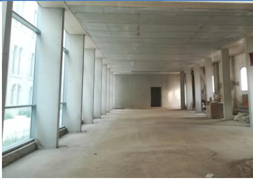
PB bloque Burben antes de las obras de habilitación
