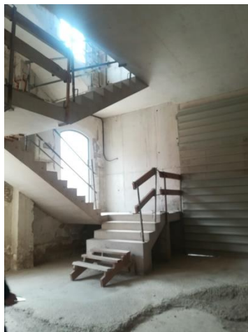
Escaleras del edificio antes de la rehabilitación
