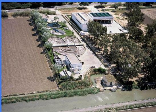
Sistema de Depuración Biológico por Fangos Activados como método de tratamiento de aguas residuales, que consiste en utilizar microorganismos para degradar y eliminar contaminantes orgánicos presentes en el agua residual.
