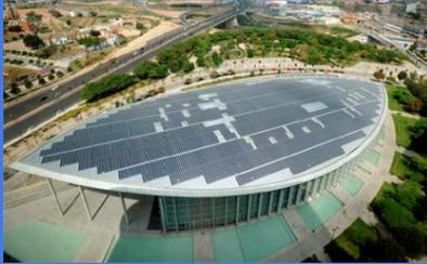
Cubierta de 8.000 m<sup>2</sup>, con claraboyas y exutorios. Y láminas fotovoltaicas integradas, con una potencia útil de 256 kw. Ensayo de instalaciones singulares, sobre todo orientadas a la sostenibilidad. La cubierta del edificio incorpora una instalación de 2.100 módulos instalados en paneles fotovoltaicos, la mayor registrada en un edificio de estas características, que ya ha generado un acumulado de más de 3,4 millones de kWh.
