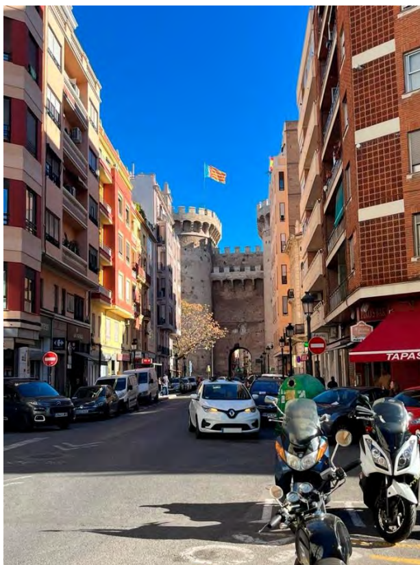
Ilustración 50: Torres de Quart
