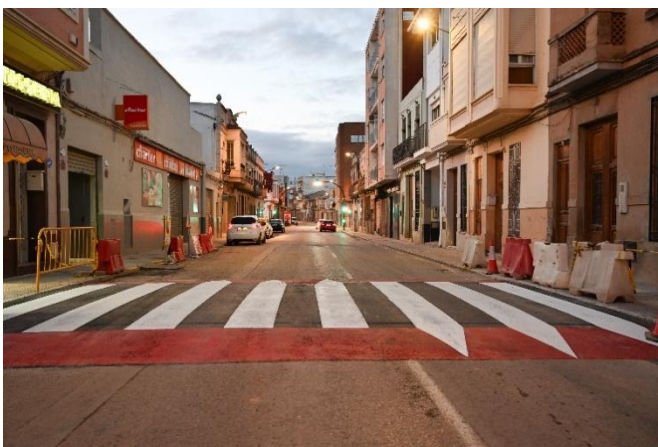
Paso sobreelevado Castellar-l'Oliveral (Pobles del Sud, 2024)
