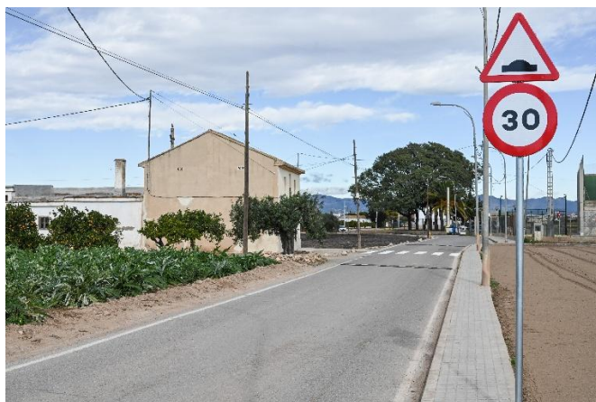
Paso peatonal Borbotó
