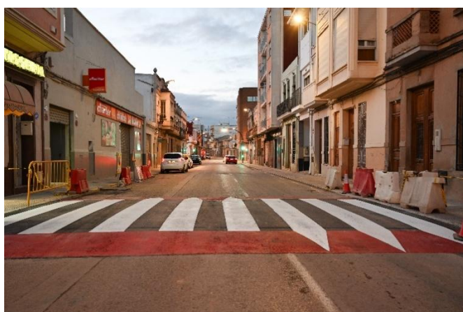
Pas sobrelevat Castellar-l'Oliveral (Pobles del Sud, 2024)
