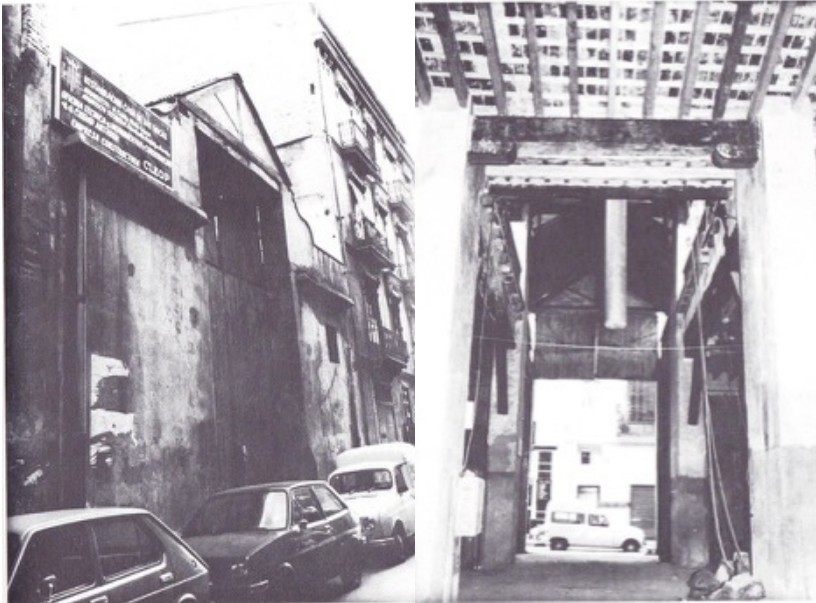
7 y 8. Detalles generales del estado de la Casa de las Rocas en los años 80, publicación del Ayuntamiento de València, 1981.
