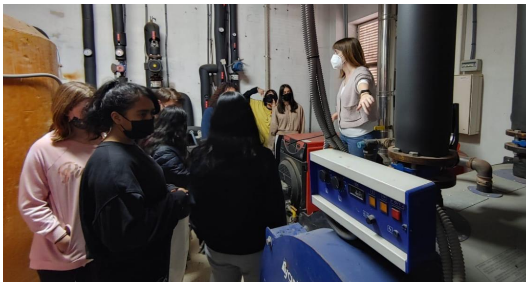
Visita a la caldera - IES Districte Marítim
