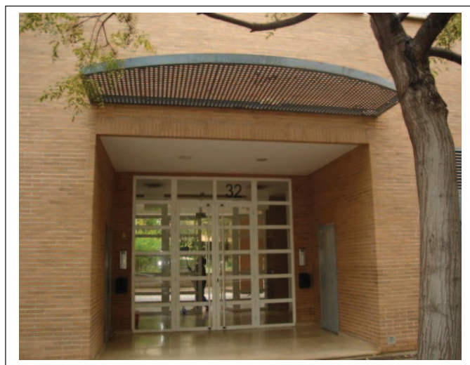
Puerta acceso edificio
