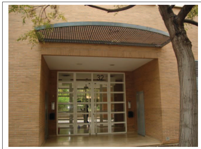
Puerta acceso edificio
