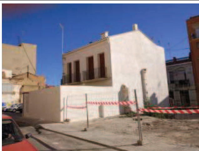
Vista posterior edificio
