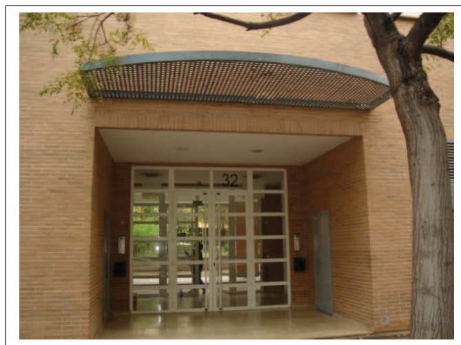
Puerta acceso edificio
