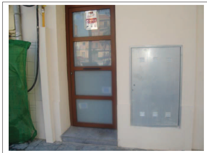
Puerta acceso edificio
