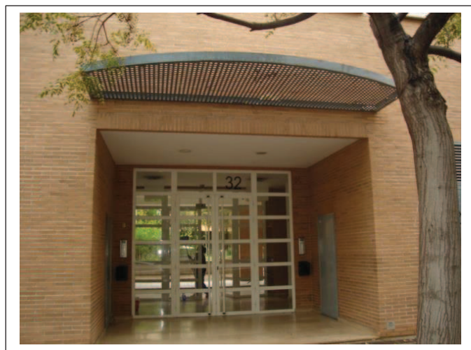
Puerta acceso edificio
