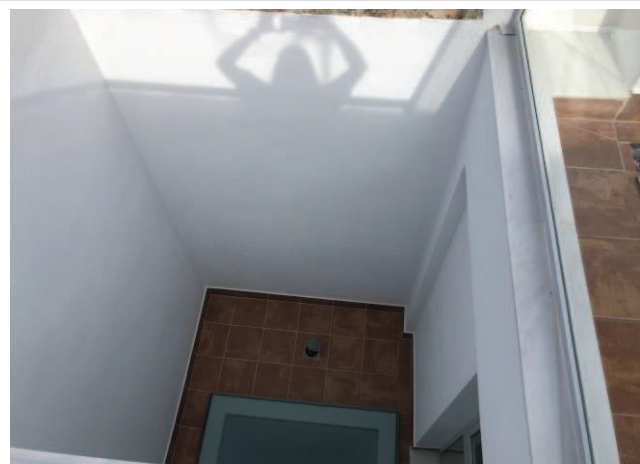
Patio interior edificio
