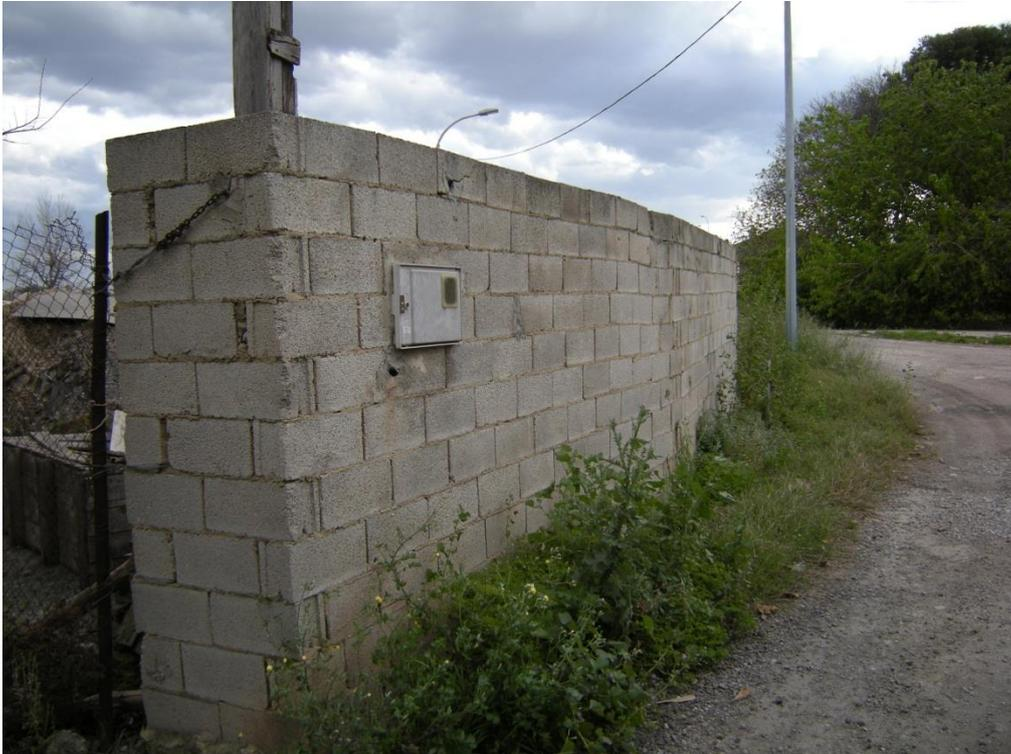
**Fotografía 2: Muro de bloque de hormigón, ubicado en la linde oeste de la parcela de 2 metros de altura (75 ml).**
