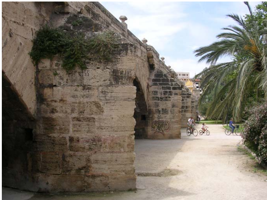
12.- PUENTE DEL REAL
