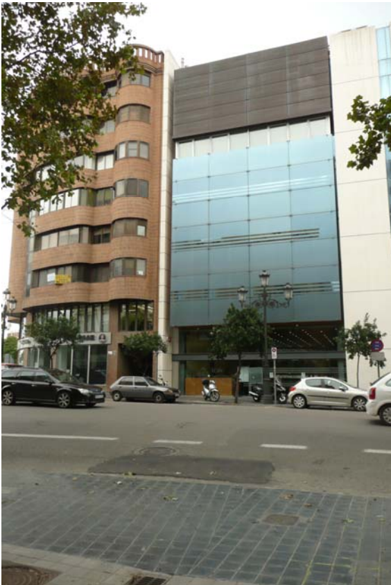
Vista del Colegio de abogados
