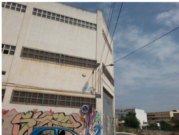
Imágenes 4.-Paso de servicios por fachada de la antigua harinera.
