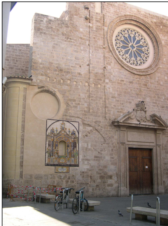
Retablo situado en la fachada principal de la iglesia.
