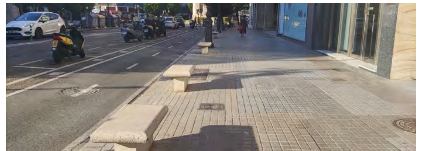
Bancs actuals del carrer Colon, que no s'adeqüen a les necessitats d'estada i descans.
