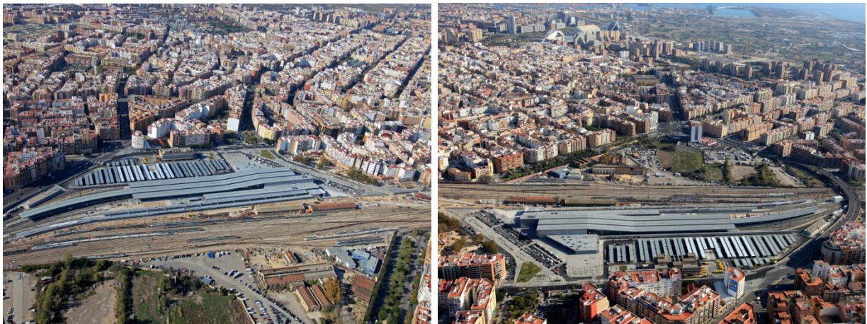
Vista aérea de la Estación provisional del AVE Joaquín Sorolla y las vías de RENFE
