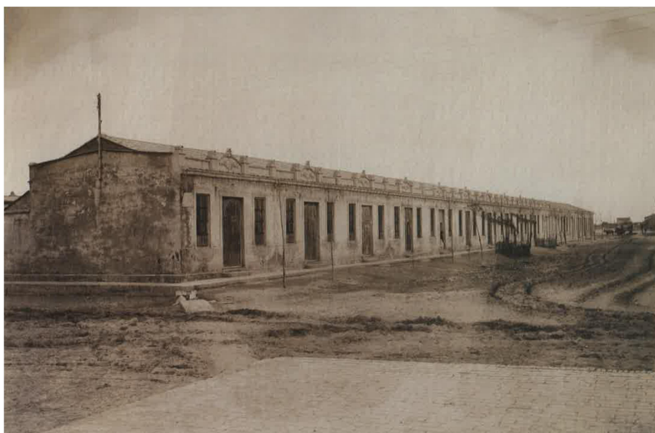
Fotografía 5. Barrio de los tranviarios, 1916.
