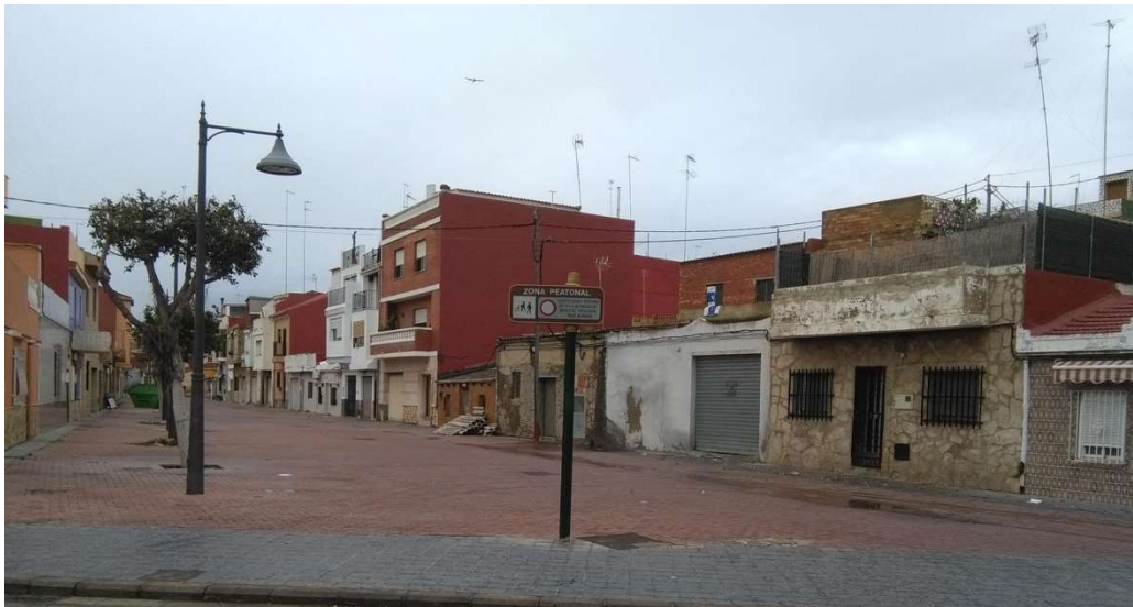
Fotografía 9. Viviendas de la calle Tabarca.
