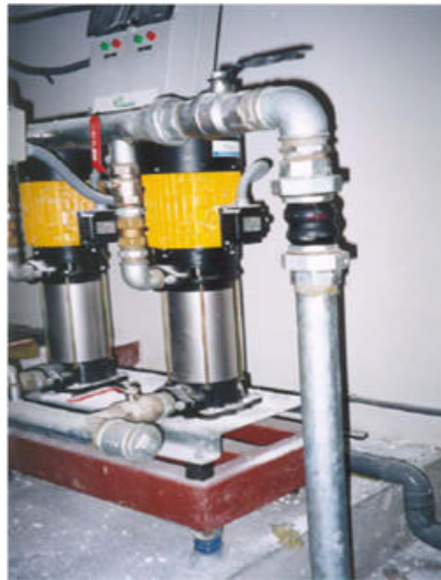
Fotografía 5. Detalle de colocación de amortiguadores para anclaje de máquinas.
