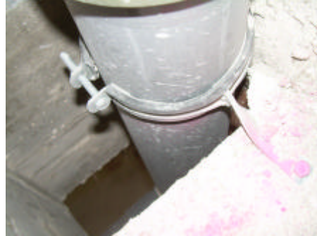
Fotografía 7-8. Colocación de elementos elásticos en las bridas de anclaje de las bajantes del edificio.
