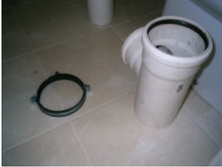
Fotografía 7-8. Colocación de elementos elásticos en las bridas de anclaje de las bajantes del edificio.
