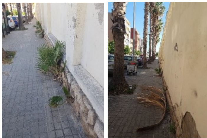
Figura 2: Detalle de algunas de las plantas y su posición en base de muro.
