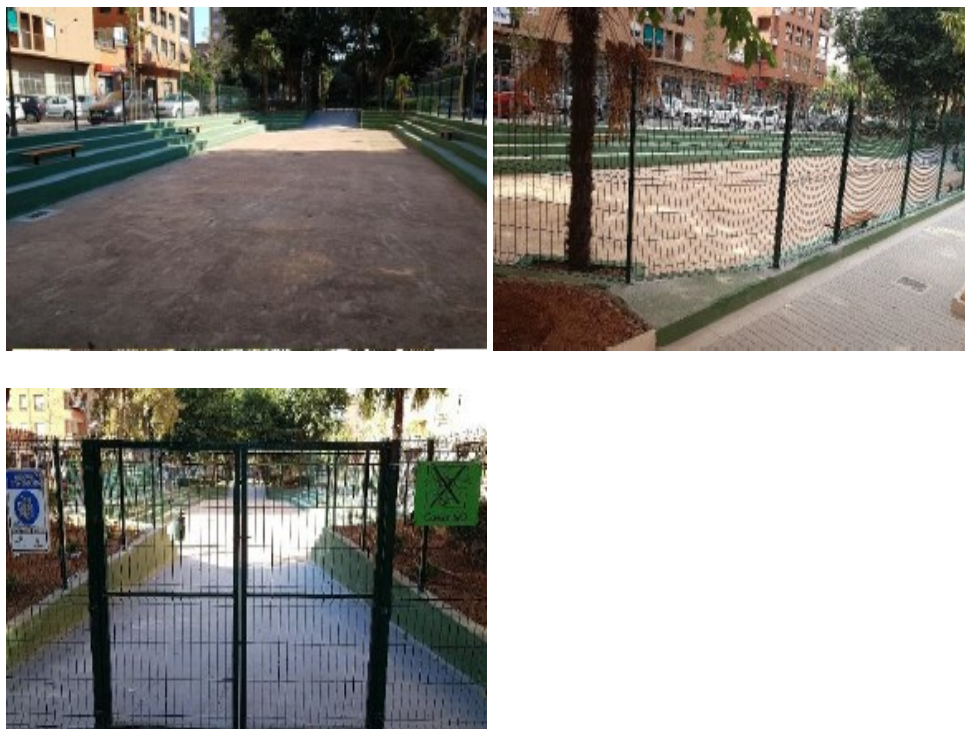
Figura 1: Interior del parque, vallado perimetral y puertas del parque.
