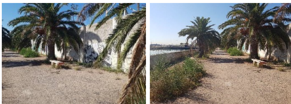
Figura 3: estado actual del vallado
