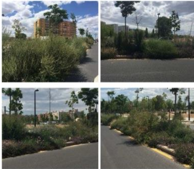
Figura 4. Calzada invadida por el descuido en el mantenimiento de la zona verde, afectando a la circulación de vehículos.
