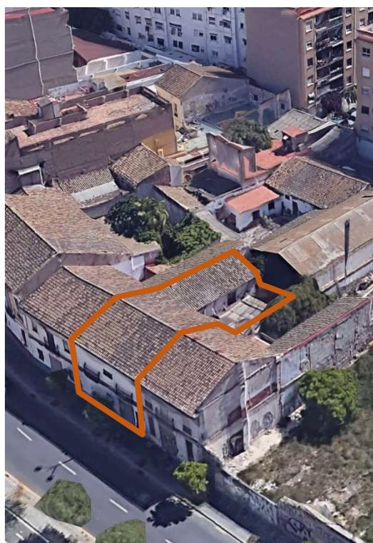
Se puede apreciar por las fotos que el estado de la edificación no se corresponde con el de la fachada, siendo el estado del resto de la edificación deficiente sin llegar a considerarse en ruina física.
