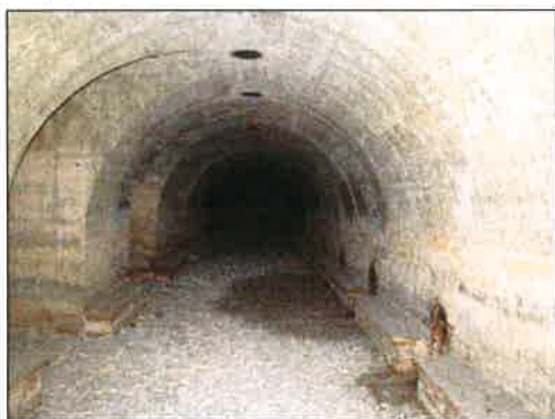
Galería del refugio con restos de barro de la riada de 1957
