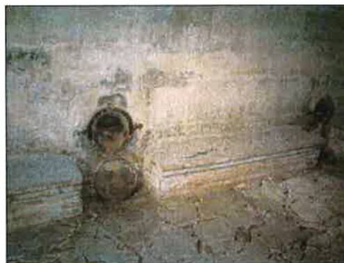
Restos de la maquinaria para renovación del aire
