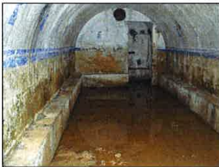
Vista de una sala del refugio
