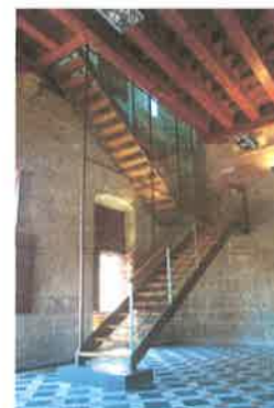
Vista interior de la escalera situada en el vestíbulo de la Sala de la Escrivanía
