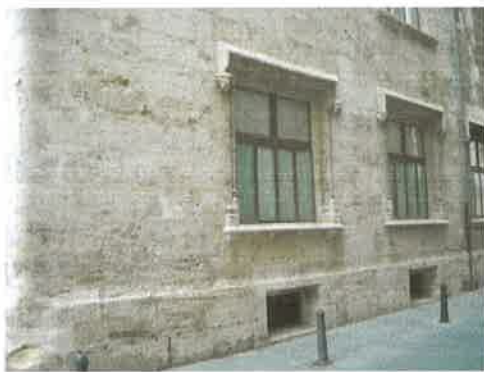
Vista del detalle de las ventanas de la Torre Vella
