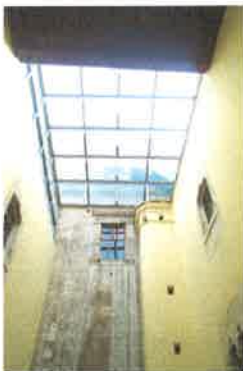
Vista de la cubrición del patio del cuerpo principal
