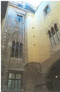
Vista de las fachadas y escalera del patio situado en el cuerpo inicial
