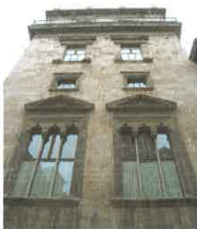
Vista de la Torre del cuerpo ampliación
