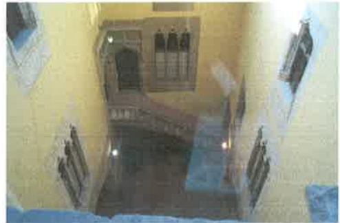
Vista de la escalera situada en el patio del cuerpo inicial
