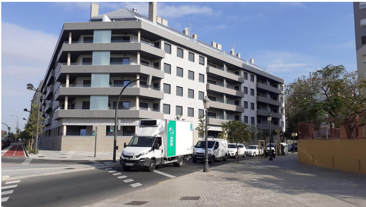
Estado de la urbanización ya finalizada (09/07/2021)
