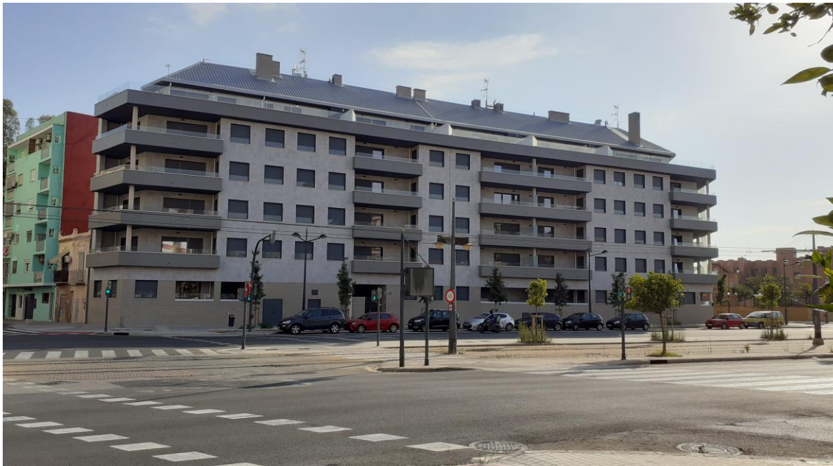
Vista del edificio recayente a la avenida de los Naranjos a 09/07/2021
