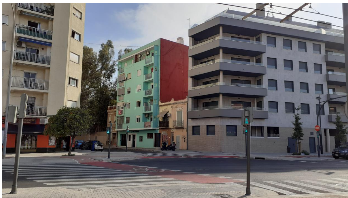
Estado de la urbanización ya finalizada (09/07/2021)
