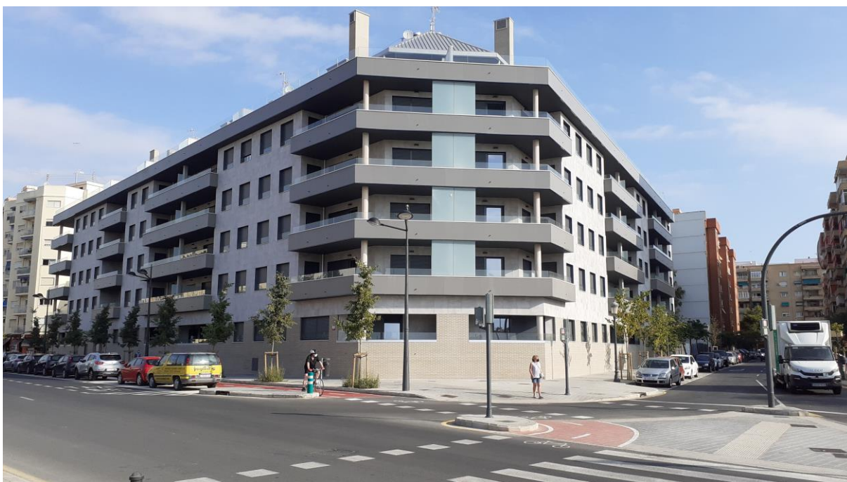
Estado de la urbanización ya finalizada (09/07/2021)
