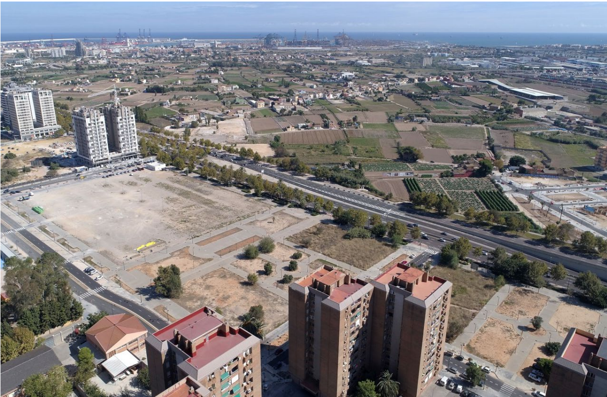
Vista aérea desde el noroeste del ámbito de actuación
