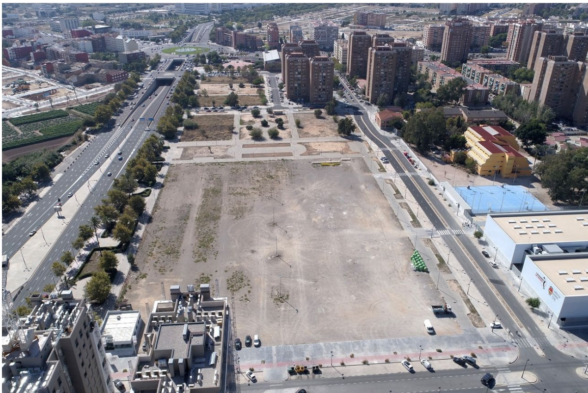
Vista aérea desde el este del ámbito de actuación
