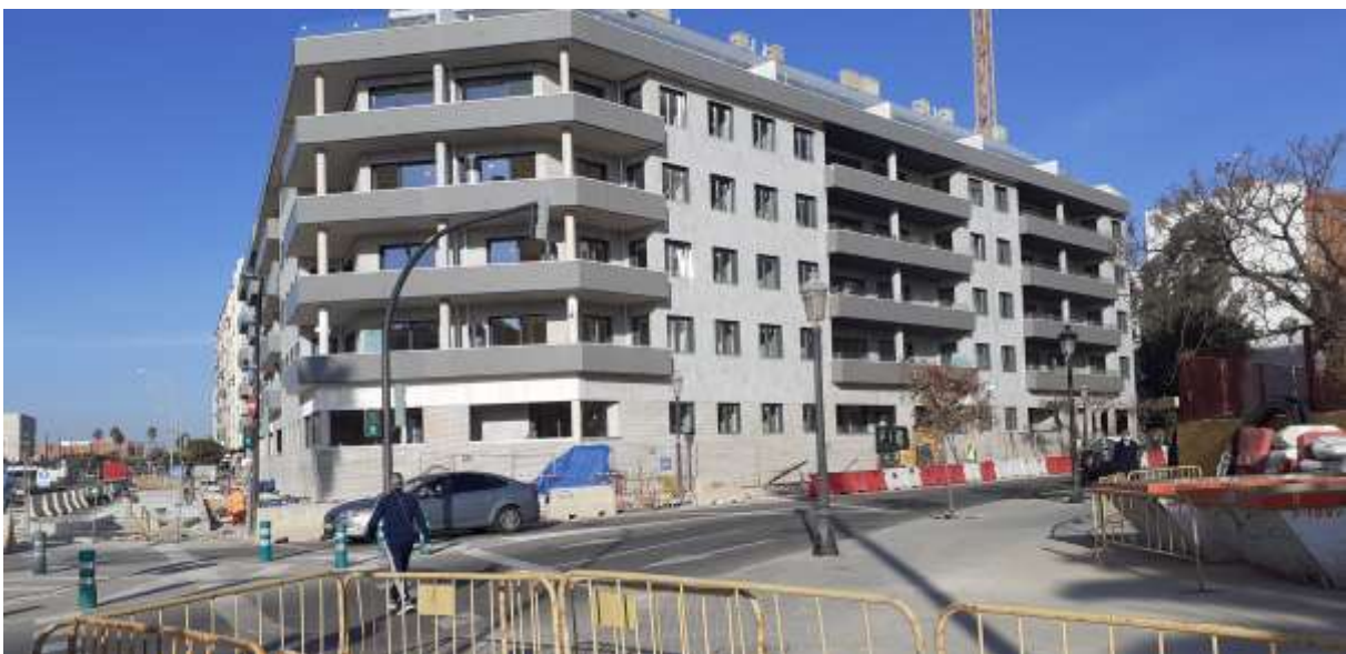
Estado de las obras de urbanización a 24/11/2020
