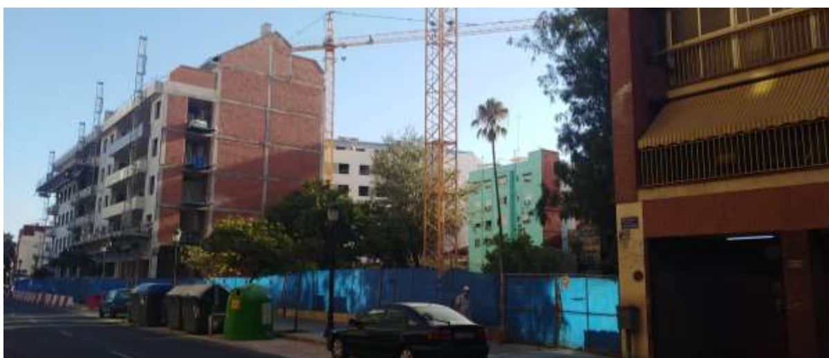
Vista del frente viario de la Avenida Malvarrosa (06/08/2020)
