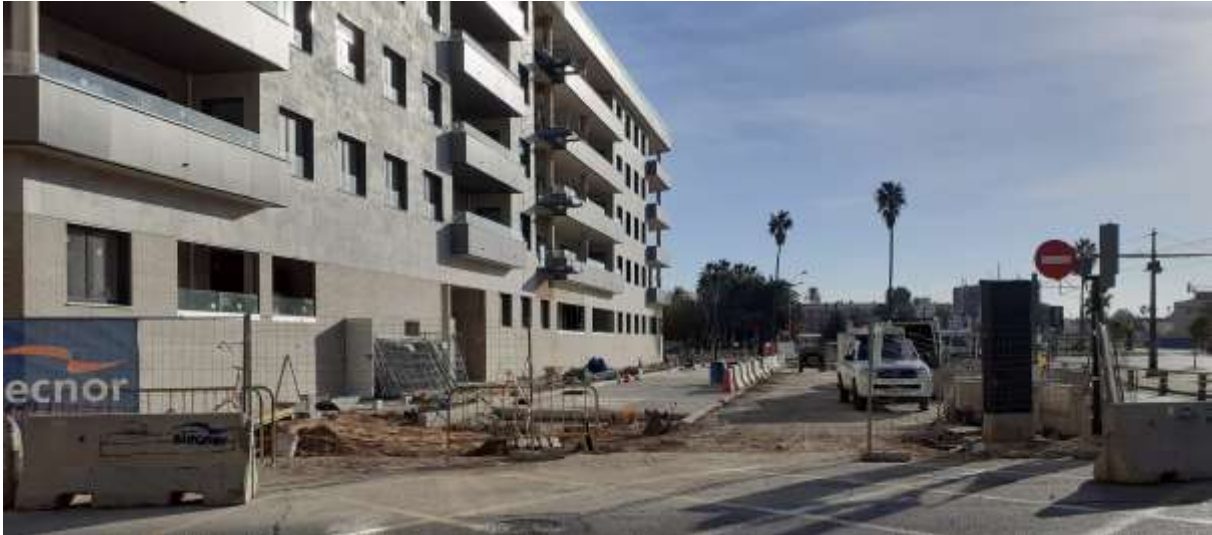
Estado de las obras de urbanización a 24/11/2020
