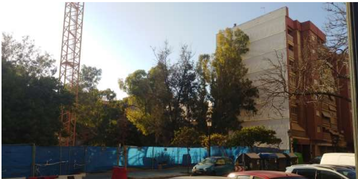
Vista del frente viario de la Avenida Malvarrosa
