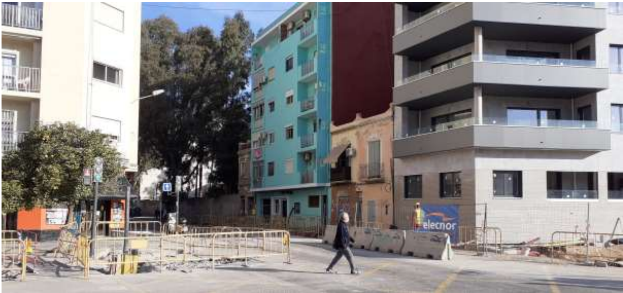
Estado de las obras de urbanización a 24/11/2020
