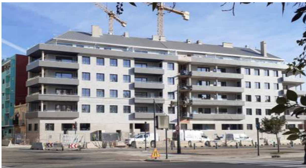
Vista del estado de las obras del edificio recayente a la avenida de los Naranjos a 24/11/2020
