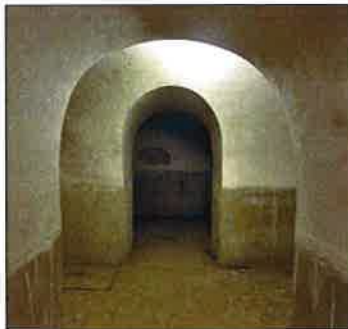
Vista transversal de tres salas del refugio
