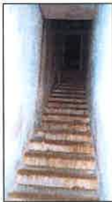
Escalera de acceso actual
