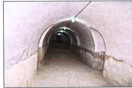
Vista de una de las salas del refugio
