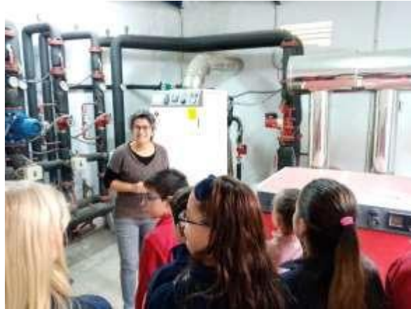
Sesión 3. Recorrido térmico. Visita a la sala de calderas.
