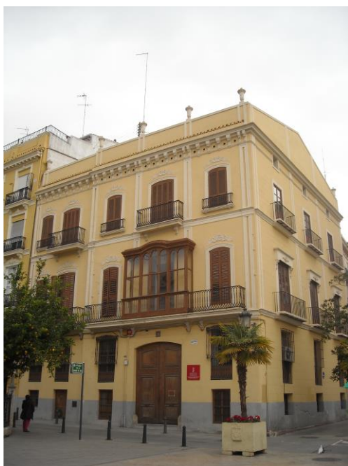
Casa acomodada de façana eclèctica en carrer de Bailia 1
