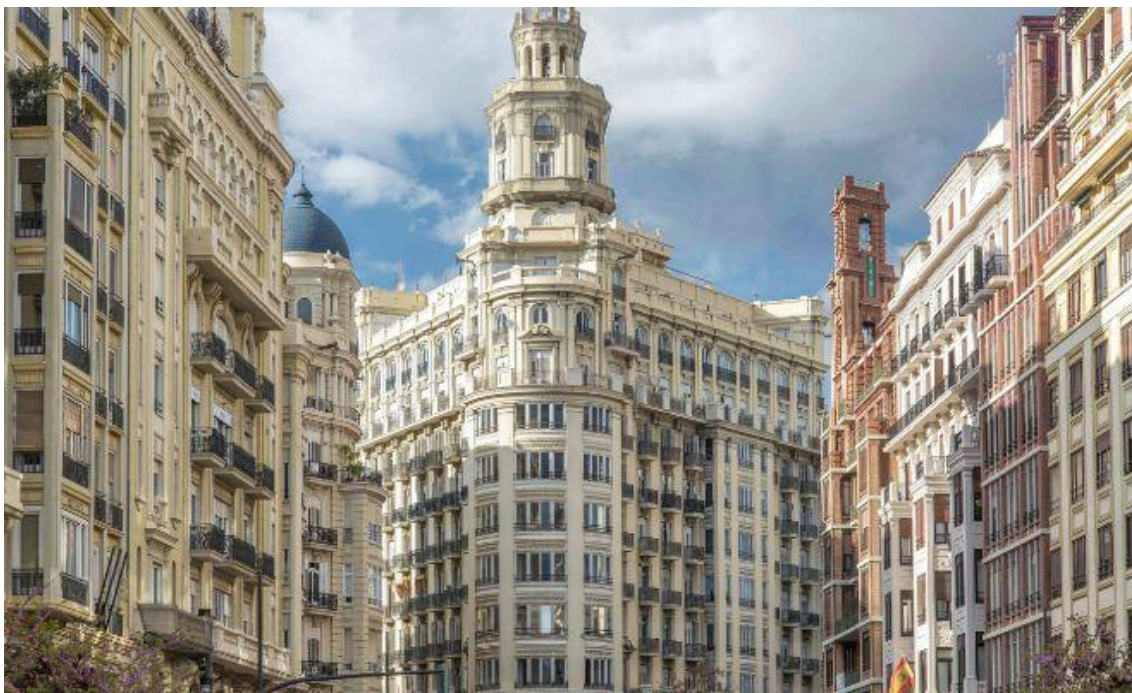
Vista des de la plaça de l'Ajuntament, on s'observa el nou paisatge urbà configurat pels nous edificis en zones de reforma urbana.
