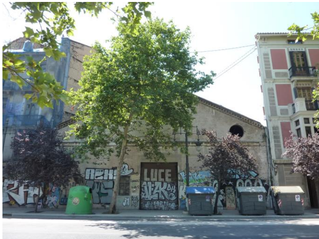
Nau industrial en carrer Guillem de Castro 142.
