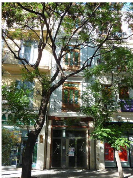
Casa obrador amb façana clàssica en plaça del Mercat 38
