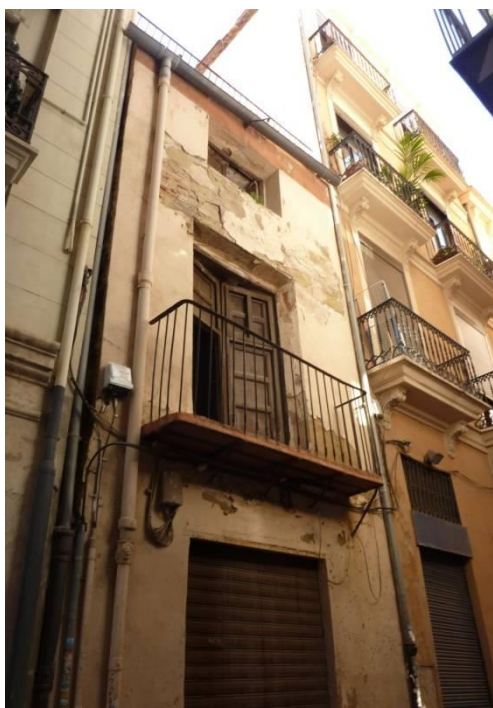
Casa obrat en carrer Aluders 3
