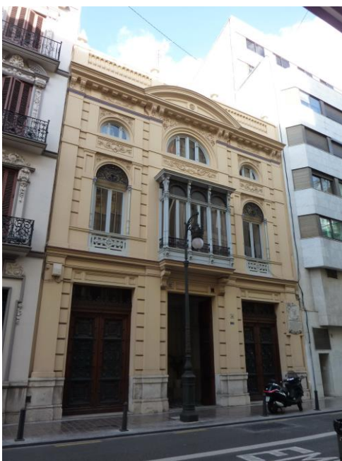
Casa de Manuel Candela en carrer Pascual i Genís 23. Arquitecte: Lucas García.
