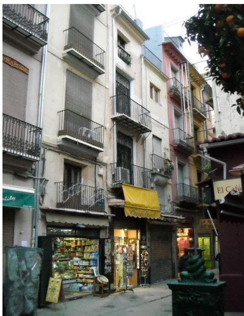
Cases obrador (edificis plurifamiliars) en carrer Trench
