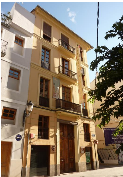
Casa veïnal amb façana clàssica en carrer Balmes 17
