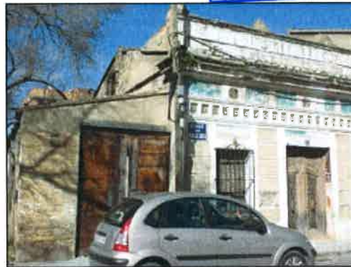
Prolongación Camino del Canal
