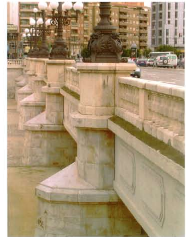
Vista lateral del puente
