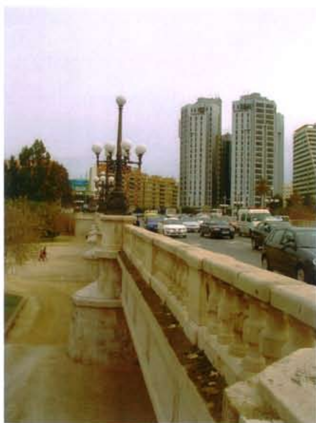
Vista lateral del puente Ángel Custodio
