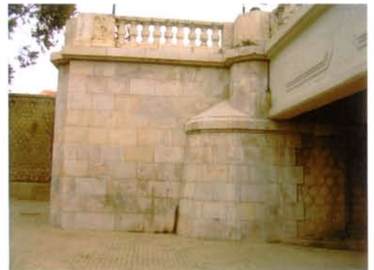
Vista detalle del encuentro entre el Tajamar y el núcleo que delimita el puente en los laterales
