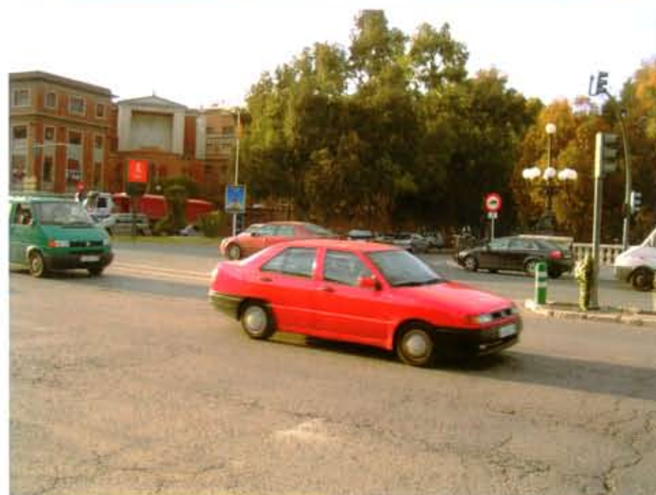
Vista intersección del puente con Avenida Jacinto Benavente
