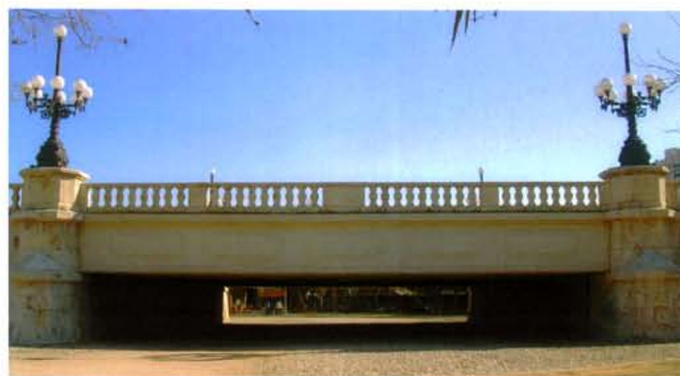
Vista módulo del puente
