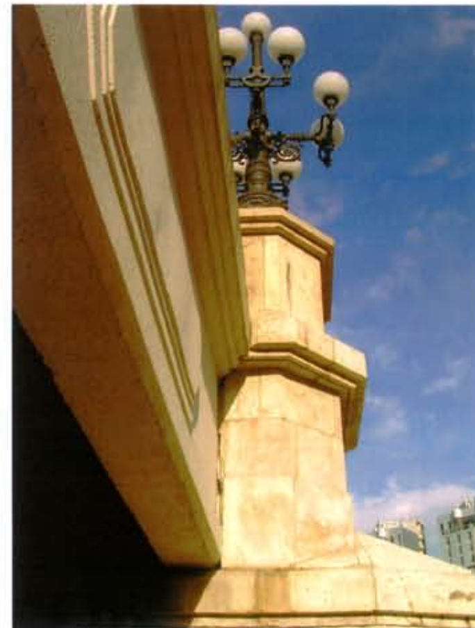
Vista de perfil del Tajamar
