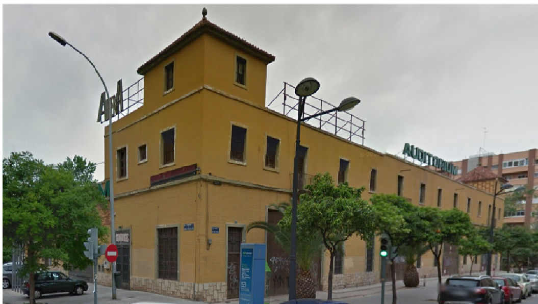
Edificio de "La Patatera". Estado actual.
