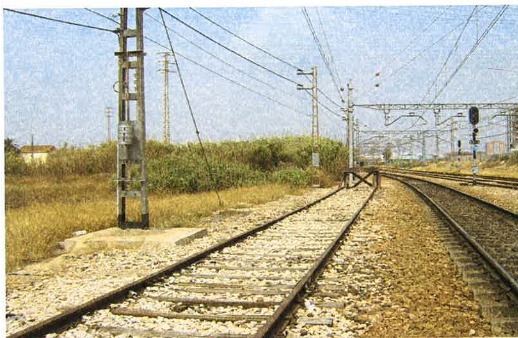
Vista de la línea férrea Valencia-Castellón a su paso por la estación de Fuente de San Luis.
