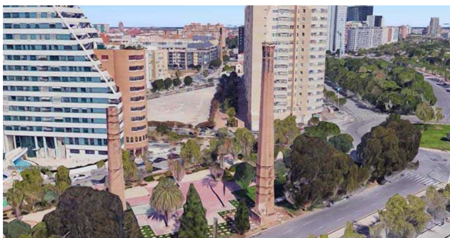
Imagen del Ámbito-3 en cuyo entorno se ubican las chimeneas
