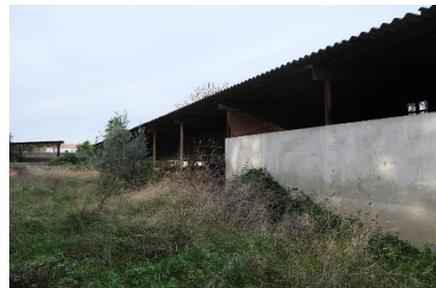
DESCRIPCIÓN: Edificación industrial a base de pórticos estructurales de acero y cubierta de placas de fibrocemento.
