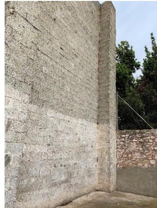
DESCRIPCIÓN: Edificación a base de fábrica de ladrillo y cubierta de placas de fibrocemento. Afección parcial.
