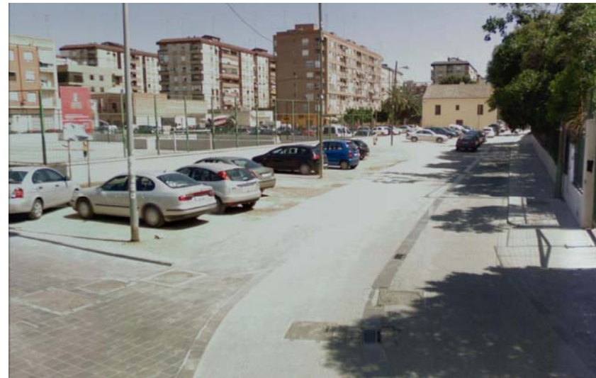
8_ CALLE GRABADOR DE ENGUÏDANOS. Dirección sur.
