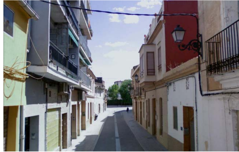
2_ CALLE GRABADOR DE ENGUÏDANOS. Dirección sur.
