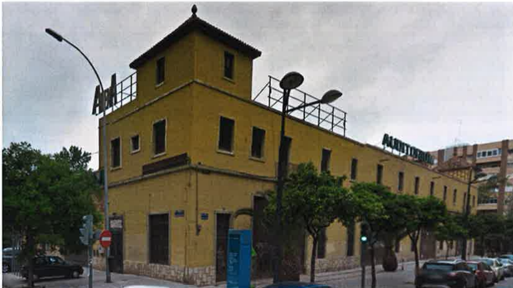
Edificio de "La Patatera". Estado actual.
