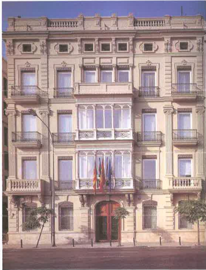
Aspecto exterior del edificio
