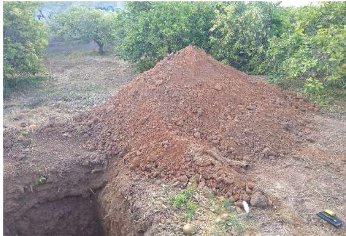
Fotografía 33: Vista del material excavado en la calicata 1.
