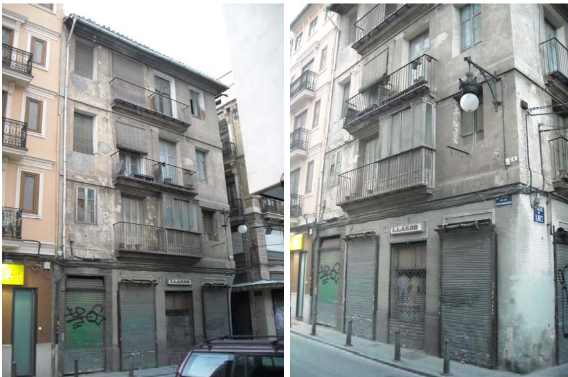
Imágenes de la fachada de la edificación existente desaparecida recayente a la calle Calabazas
