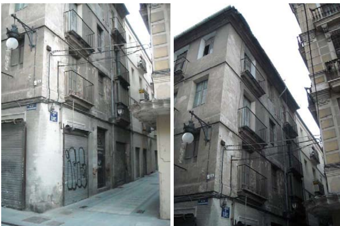
Imágenes de la fachada desaparecida recayente a la calle Blanes
