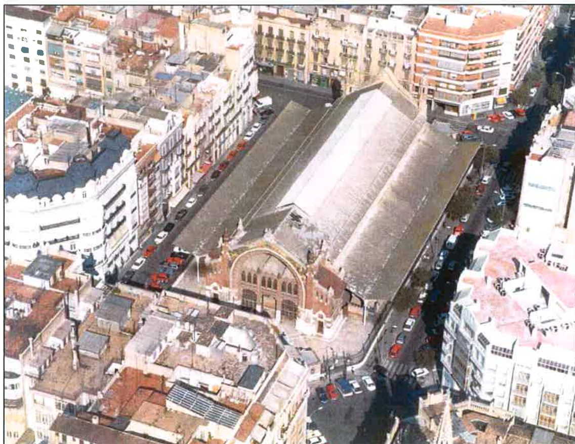
Fotografía Aérea del Mercado de Colón
