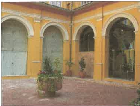
Vista interior patio (Fuente: www.jdiezarnal.com )
