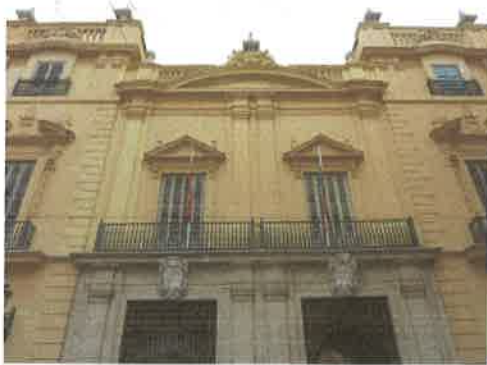
Vista fachada principal recayente a la plaza del Arzobispo
