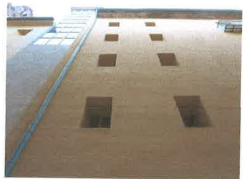
Fachada zona ampliación desde calle de la Llimera
