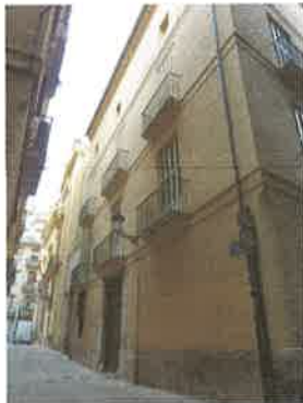
Vista fachada de la parte ampliada recayente a la calle de la Llimera
