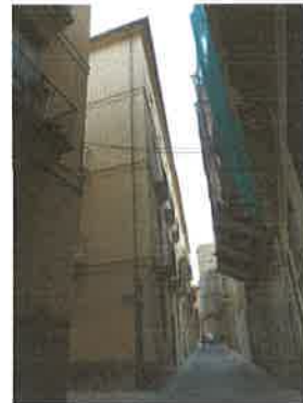
Vista de la parte ampliada recayente a la calle Venerables
