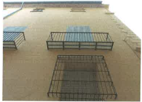
Detalle fachada desde calle de la Harina
