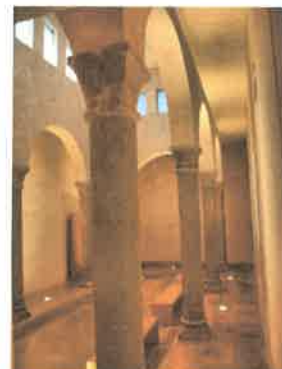
Vestíbulo tras la rehabilitación
