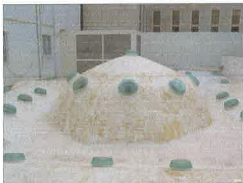
Cubierta tras la rehabilitación
