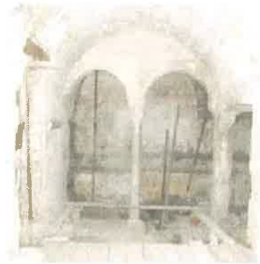
Vista interior antes de la reciente rehabilitación
