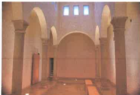
Vestíbulo tras la rehabilitación
