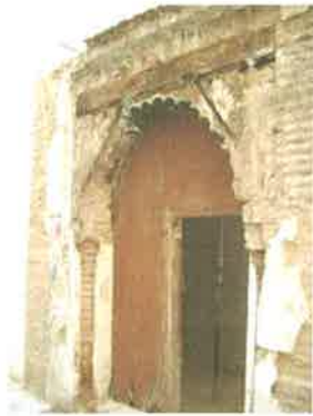
Entrada actual, antes de la reciente rehabilitación
