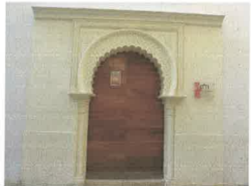
Puerta de entrada, tras la rehabilitación
