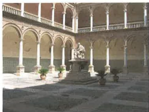
Vista del claustro
