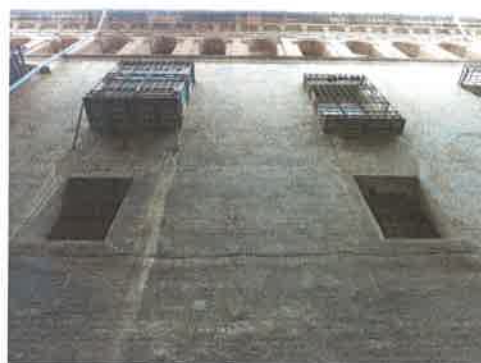
Detalle de la fachada
