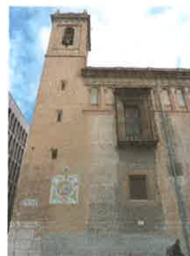
Vista de la torre campanario
