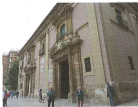
Detalle fachada recayente a la plaza de la Virgen
