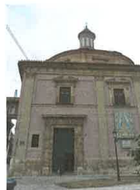
Detalle fachada recayente a la plaza de la Virgen
