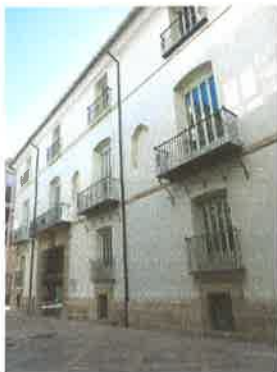
Vista fachada recayente a calle Libreros
