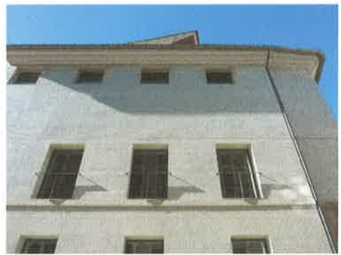
Detalle fachada recayente a calle Libreros/ plaza Colegio del Patriarca
