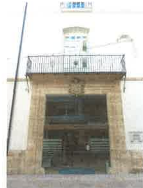
Detalle fachada recayente a calle Libreros
