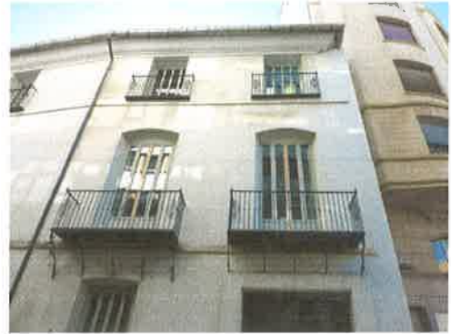
Detalle fachada recayente a calle Libreros
