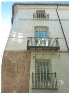
Detalle fachada recayente a calle Libreros
