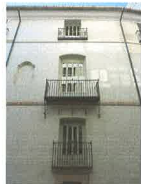
Detalle fachada recayente a calle Libreros
