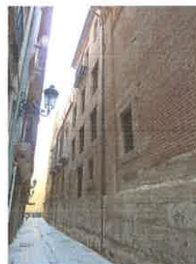
Vista fachada recayente a calle San Martín
