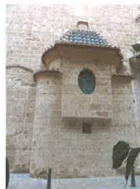
Detalle fachada recayente a calle Abadía
