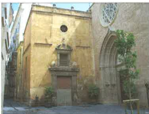
Fachada de la Capilla de la Comunión, antes de la reciente restauración
