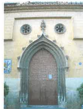
Detalle portada en fachada recayente a la plaza San Nicolas
