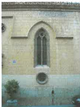
Detalle ventana en fachada recayente a la plaza San Nicolas
