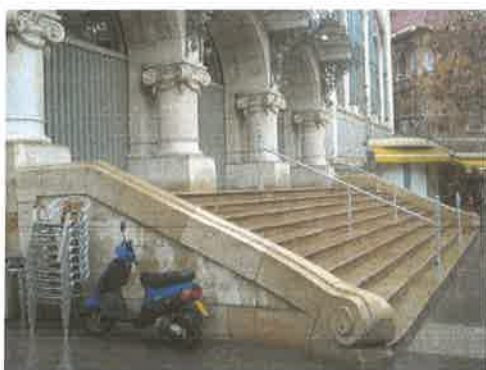
Vista escalera de entrada en fachada recayente a la plaza del Mercado
