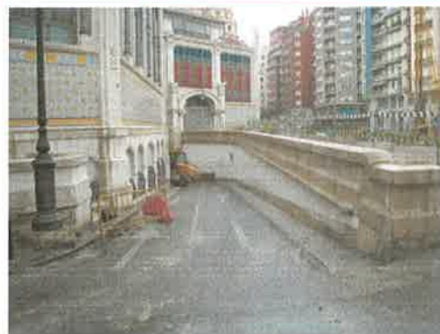
Vista rampa de bajada al sótano del mercado
