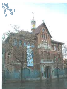
Vista fachada pabellón
