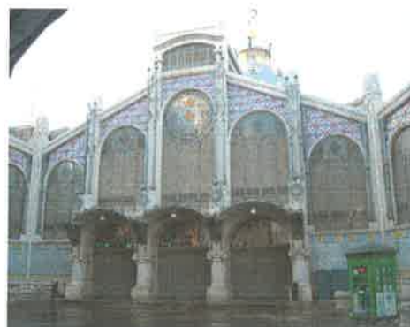
Vista fachada lateral
