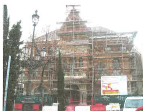
Vista fachada pabellón
