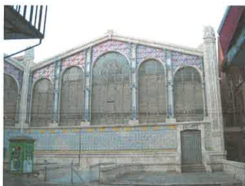
Vista fachada lateral
