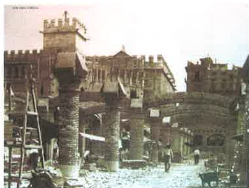
El sótano del Mercado en construcción. 1917
